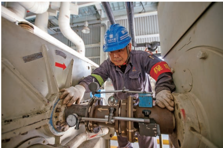
大唐环境特许经营分公司把“党建创新拓展年”与当前各项工作紧密结合，截至目前，各项目部等级检修项目陆续开工。在党员突击队的带领下，检修人员攻克各项检修难题，扎实推进各项任务如期完工。
