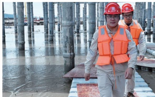
工程桩打桩质量及组件安装质量检查
