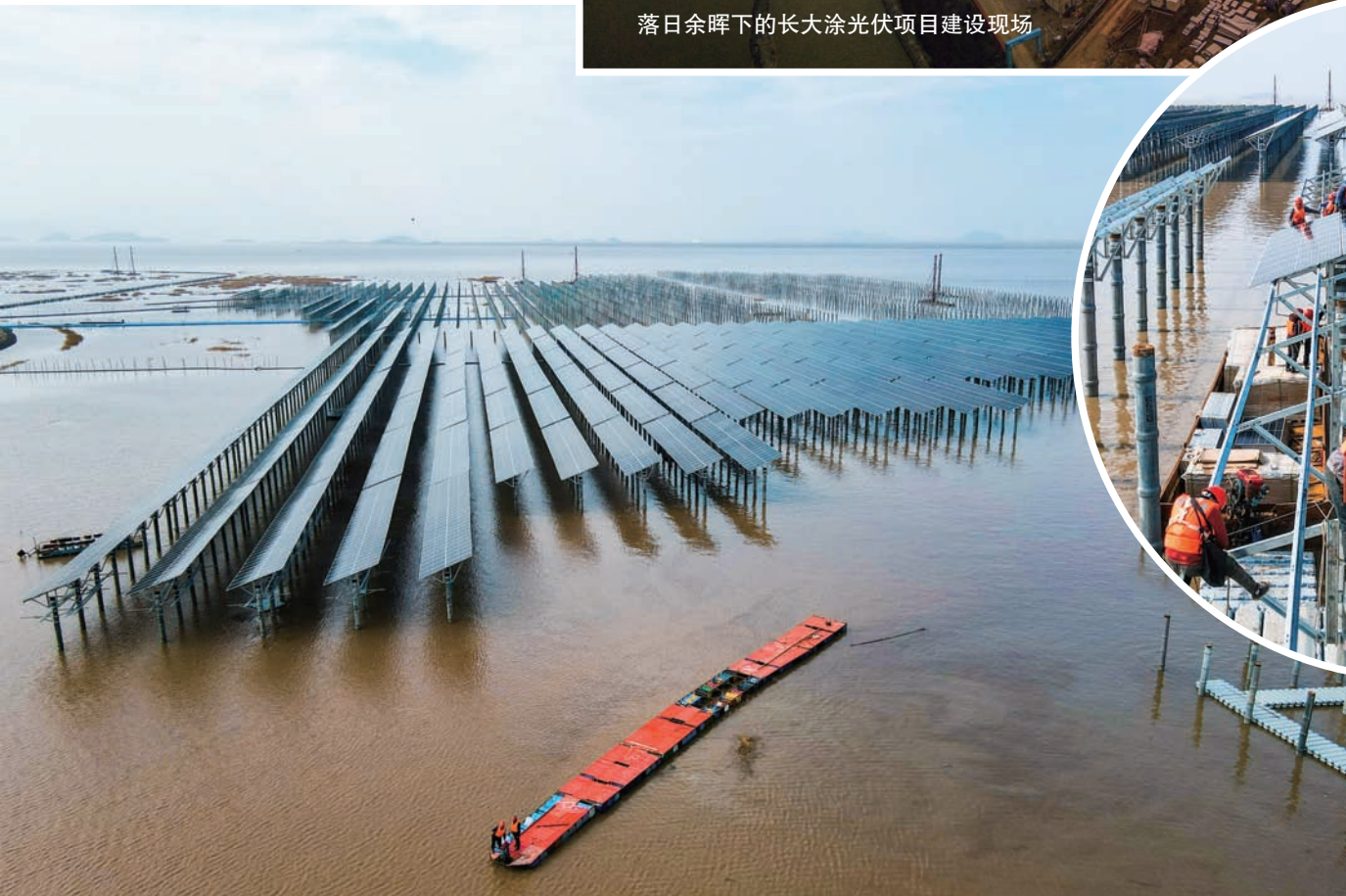
利用潮水转移作业平台
